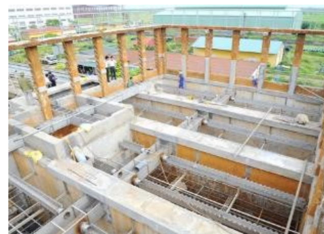
Khu xử lý NMN Việt Hoà đang cải tạo
